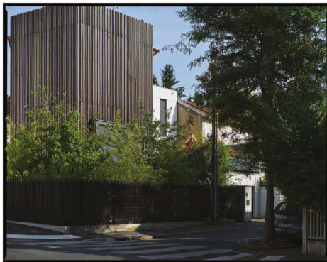
Maison d'angle (2018, BM Architects, Stéphane Béranget), prix Archirovo 2019 À DROITE La Maison perchée (2022, Étude Roi-Malherbe), prix régional de la construction bois en Île-de-France 2022 catégorie « Réhabiliter un logement ».
